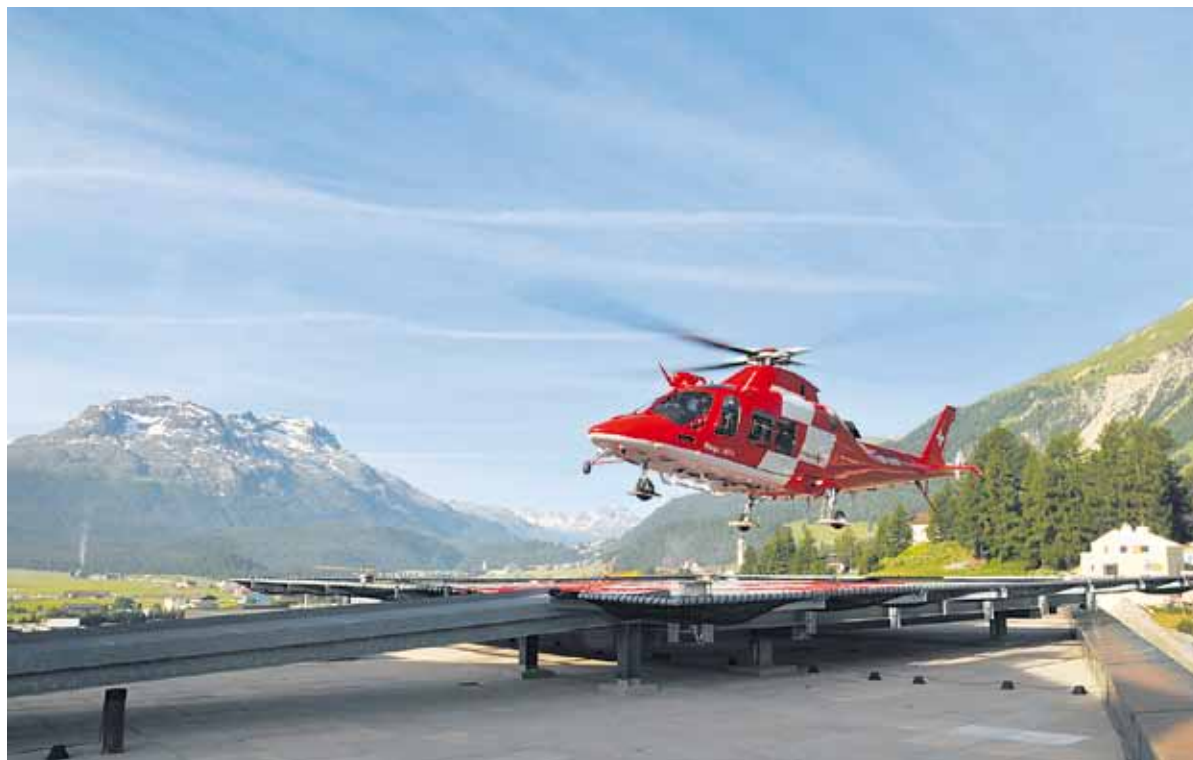
Genügt den Anforderungen nicht mehr: Der Helikopter-Landeplatz auf dem Dach des Spitals Oberengadin muss bis Ende Jahr total erneuert werden.
