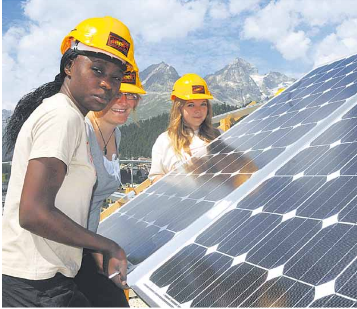
Im Einsatz zugunsten der Solarenergie: 24 Jugendliche aus drei Kontinenten haben diese Woche auf dem Dach der St. Moritzer Jugendherberge Solarpanels und eine Photovoltaikanlage installiert. Foto: Reto Stifel
