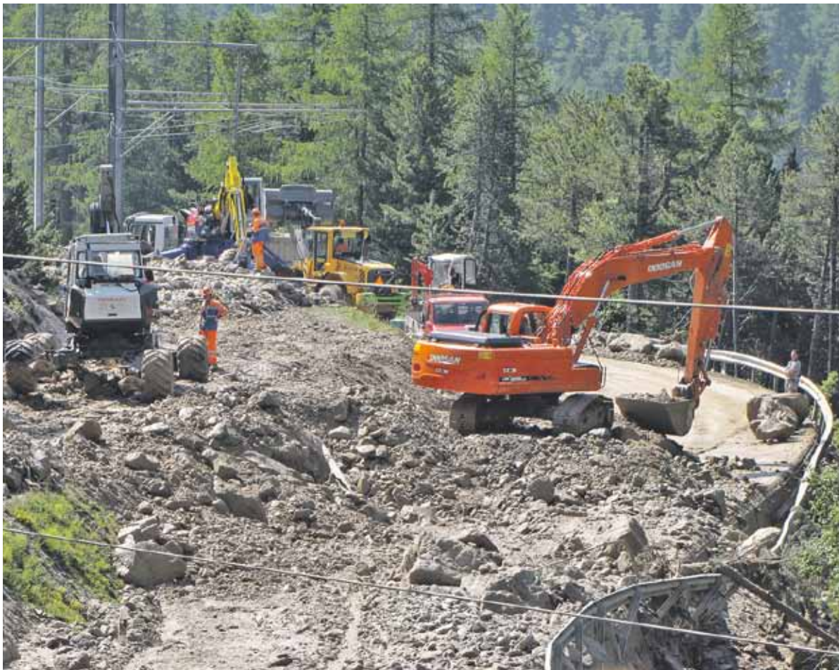
Räumungssequipen am Berninapass im Einsatz: Nach heftigem Unwetter verschütteten am Samstagabend Erdrutsche Strasse und Schiene.
