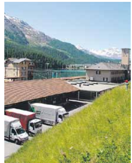
Soll rundumerneuert werden: Der Bahnhof St. Moritz
