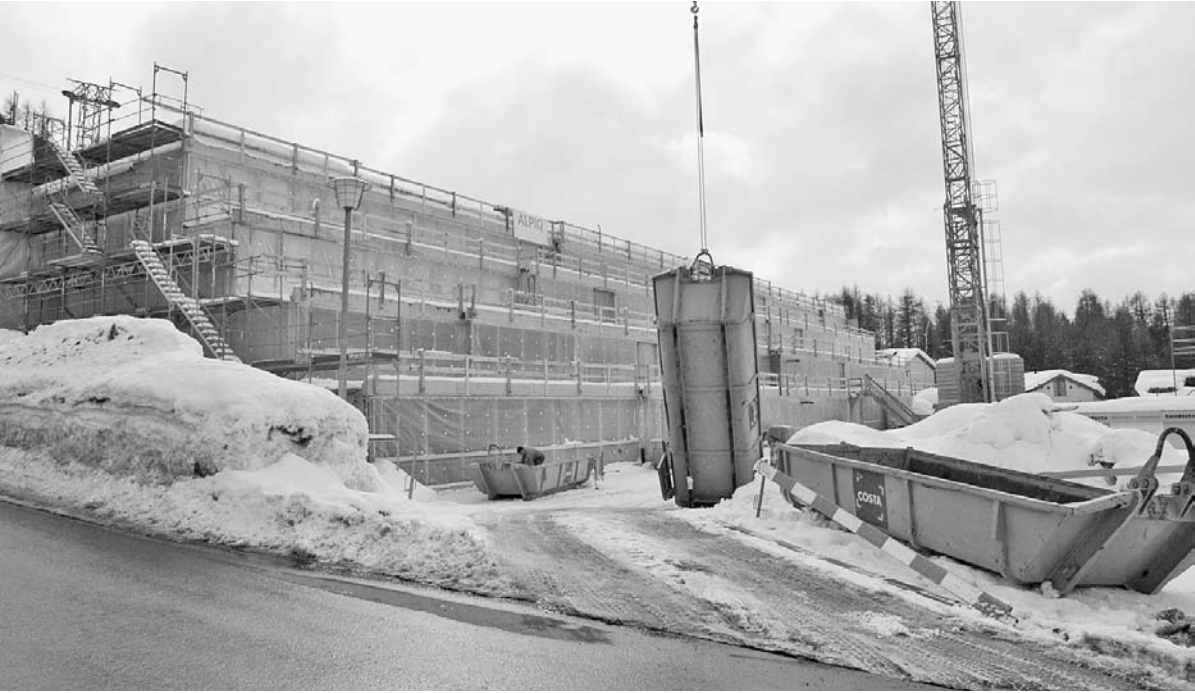
Das sich im Bau befindende Hotel bei der Talstation der Corvatschbahn in Surlej soll programmgemäss zu Wintersaisonbeginn 2010 eröffnet werden.
