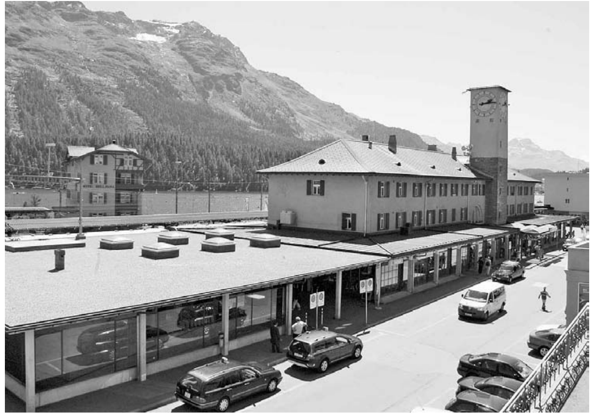
Das Bahnhofareal St. Moritz soll im Sinne eines städtebaulichen Fortschrittes erneuert werden.
